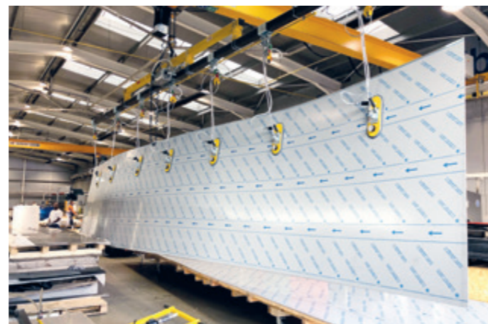
VacuBoyVario VBV-250KG Aufstellen von Kunststoffplatten mit einer Länge bis zu 8.000 mm
