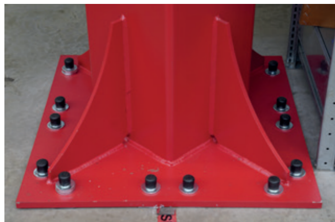
Dynamische Dübelbefestigung Über Grundplatte direkt auf dem Hallenboden verdübelt.
